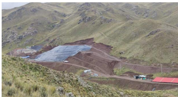
Figura 1. Ubicación y estado de las celdas transitorias y poza de lixiviados de Huanuyo
