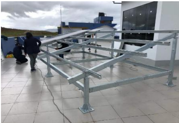
Figura 7. Montaje de estructura de soporte de fierro galvanizado para una inclinación de 15° y una orientación al NG
