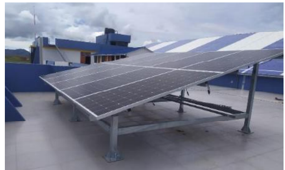
Figura 8. Montaje de paneles fotovoltaicos modelo BSP370M
